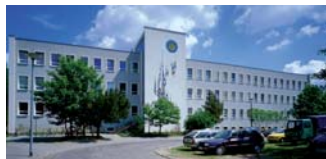
Außenansicht Komplexgebäude – hier befinden sich die Seminarräume
